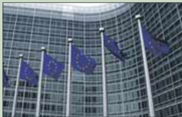
La sede della Commissione Ue
